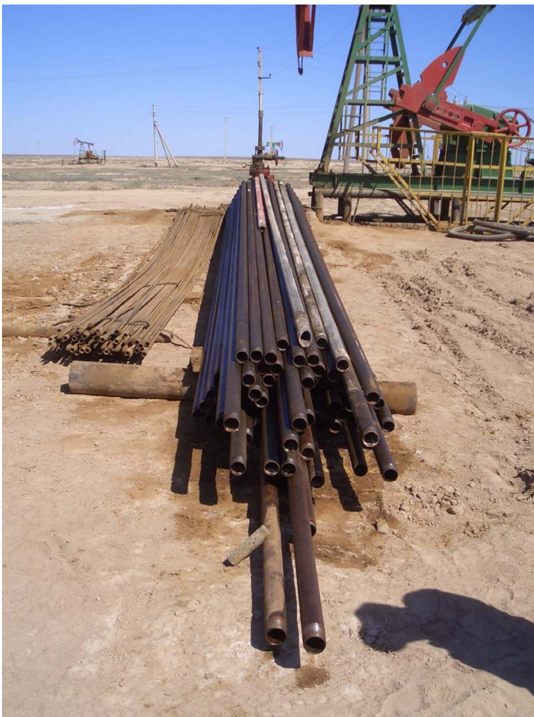
НГДУ Макатмунайгаз . Месторождение Вост. Макат. Подъем НКТ и насосных штанг для ремонта и технического обслуживания
