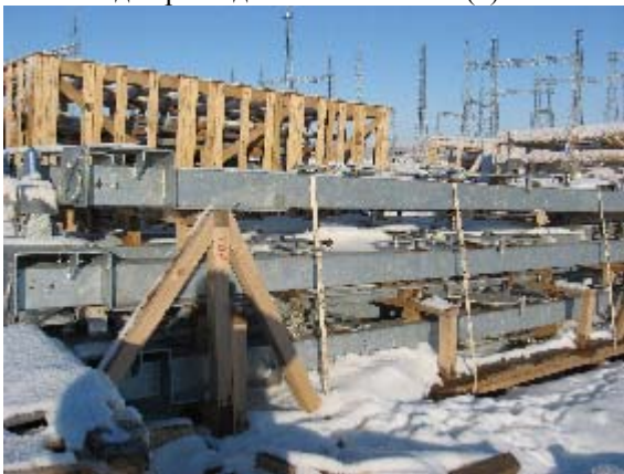
Фото 65. Навесное оборудование для разъединителей 500 кВ (3)
