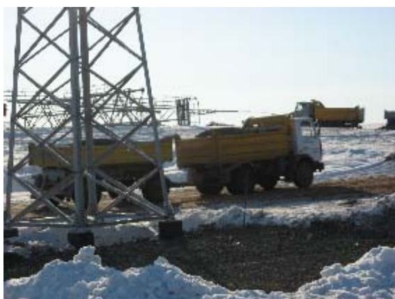
Фото 51. Доставка песка, щебня, грунта
