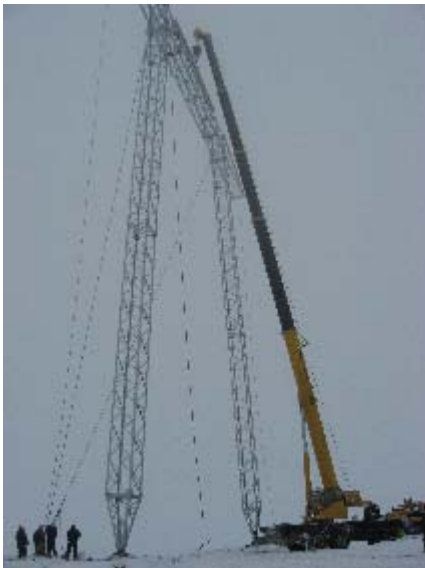
Фото 45. Установка опор (6)
