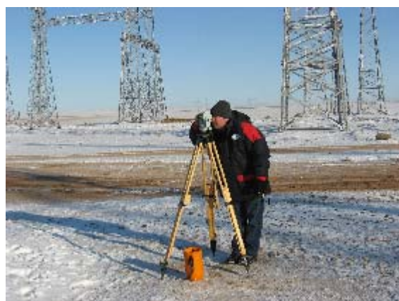
Фото 50. Нивелирование отметок фундамента
