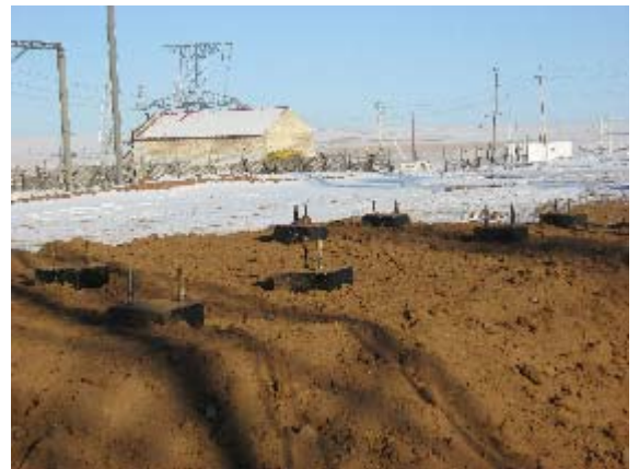
Фото 58. Установленные фундаменты (2)
