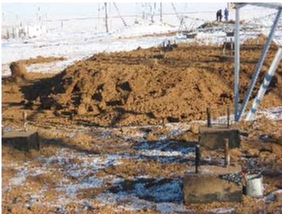
Фото 57. Установленные фундаменты (1)
