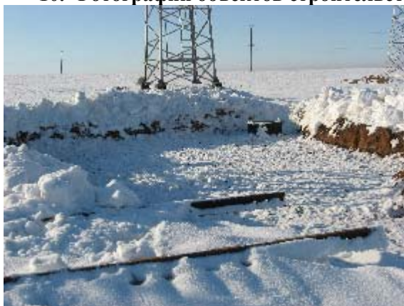
Фото 47. Котлован под фундамент опоры
