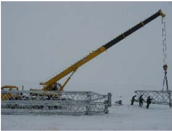
Фото 43. Установка опор (4)
