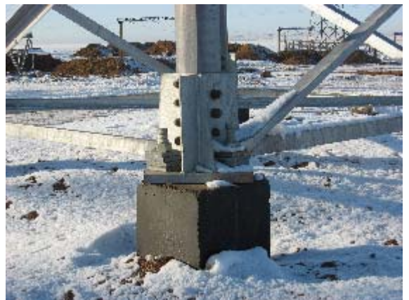
Фото 68. Крепление конструкции с фундаментом
