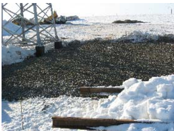
Фото 49. Котлован и продольный путь перекатки
