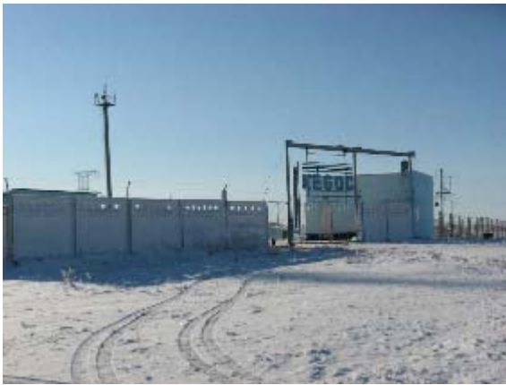
Фото 1. Действующая станция АО «КЕГОС» (1)
