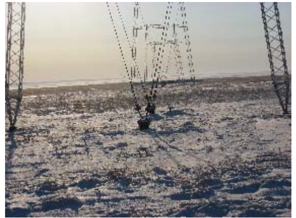
Фото 31. Крепление опор к анкерам
