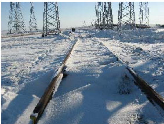
Фото 7. Продольные пути перекачки (1)
