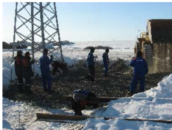
Фото 48. Обратная засыпка котлована грунтом
