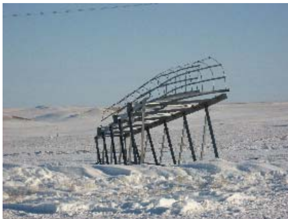
Фото 15. Металлоконструкция для опоры ЛЭП
