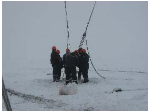
Фото 38. Процесс крепления оттяжек к анкерам
